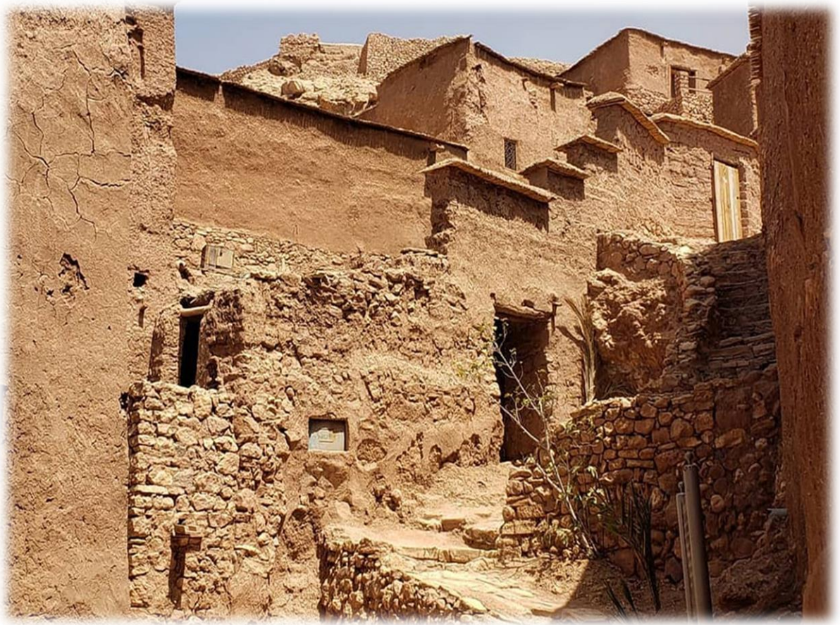
Het was de bedoeling dat we de kashba van Taourirt zouden bezoeken onderweg, maar de kashba was gesloten door de recente aardbevingen waardoor de kashba onstabiel zou zijn.
